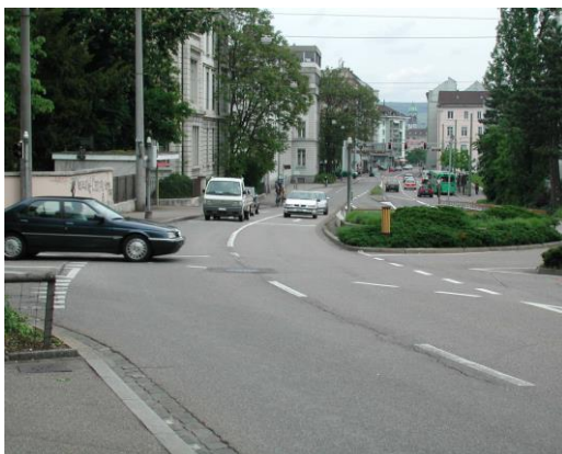
Abbildung 4: Schanzenstrasse, Basel (Quelle: Bau- und Verkehrsdepartement Basel-Stadt)
