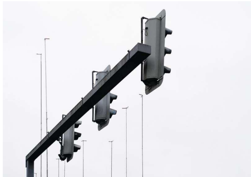
Bauen an lärmigen Strassen bleibt extrem anspruchsvoll.
