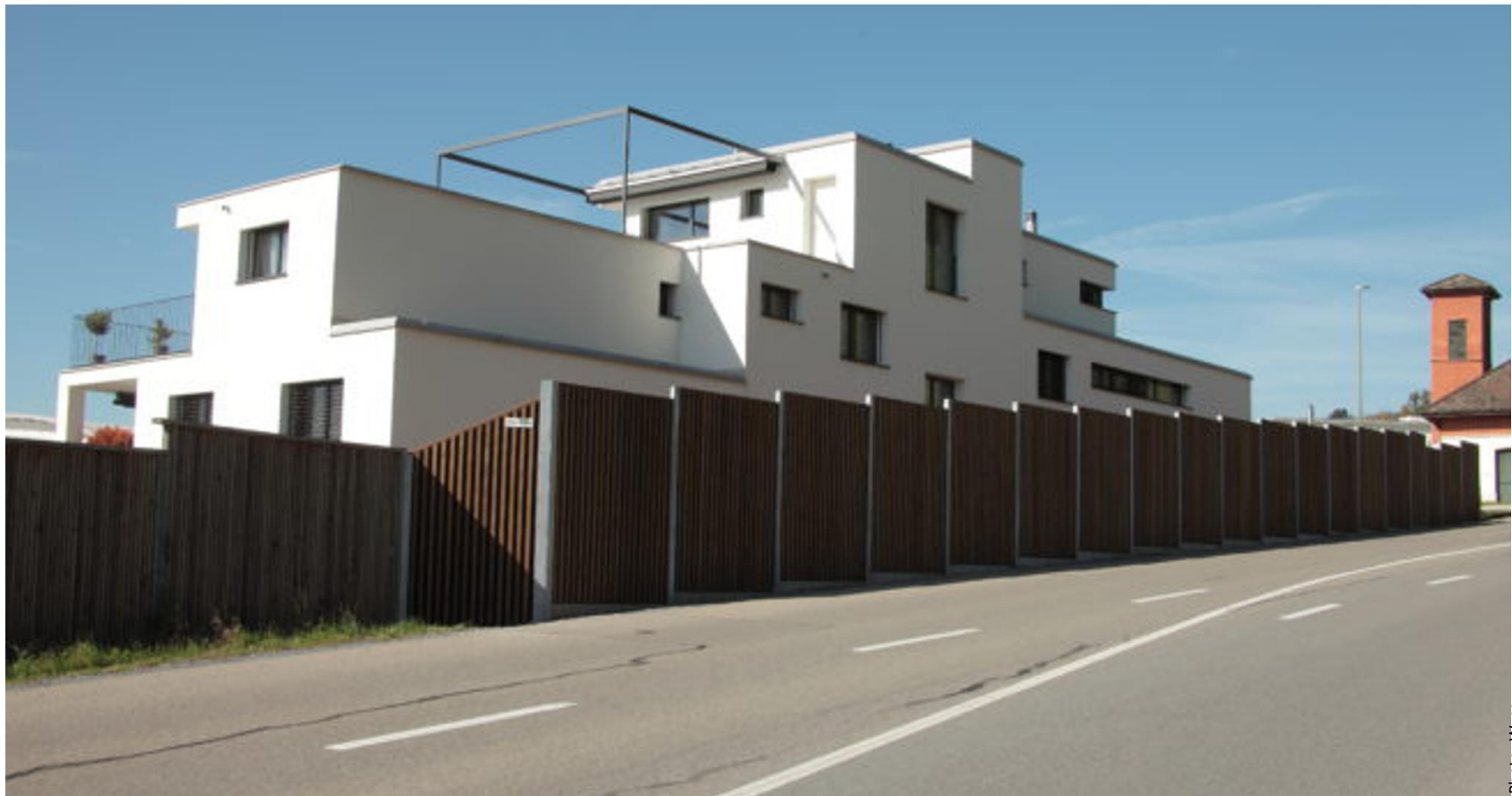
Le mur antibruit Lamaseda® de Wyss Zäune en service
