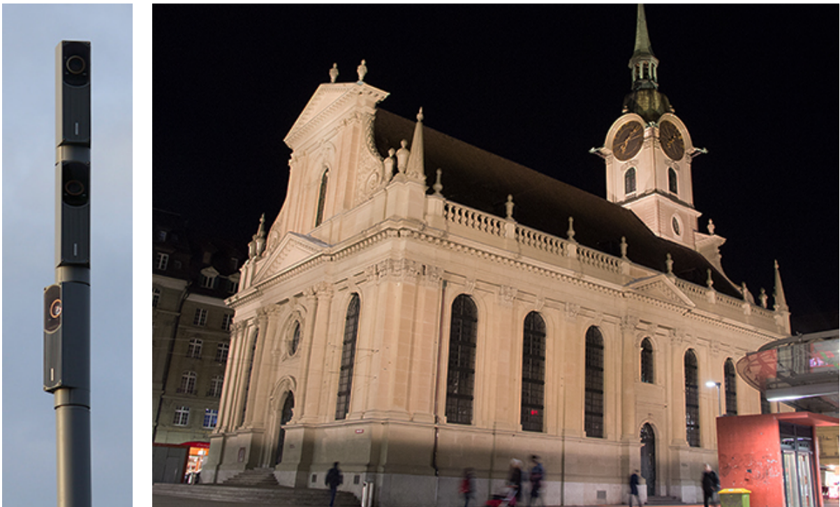
Abbildung 23: 13 Projektoren, die an sieben Standorten platziert sind und auf gegenüber liegenden Dächern sowie auf Masten der Strassenbeleuchtung (Bild links) angebracht sind, beleuchten die Heiliggeistkirche vor dem Bahnhof in Bern (Bild rechts, Quelle: Energie Wasser Bern). Durch die Verwendung von speziell angefertigten Schablonen in den Projektoren wird das Licht präzise gelenkt, es werden Helligkeitsunterschiede erzeugt sowie Details hervorgehoben, wie die Dachbrüstung mit den Vasen und Urnen auf der Längsseite der Kirche.
