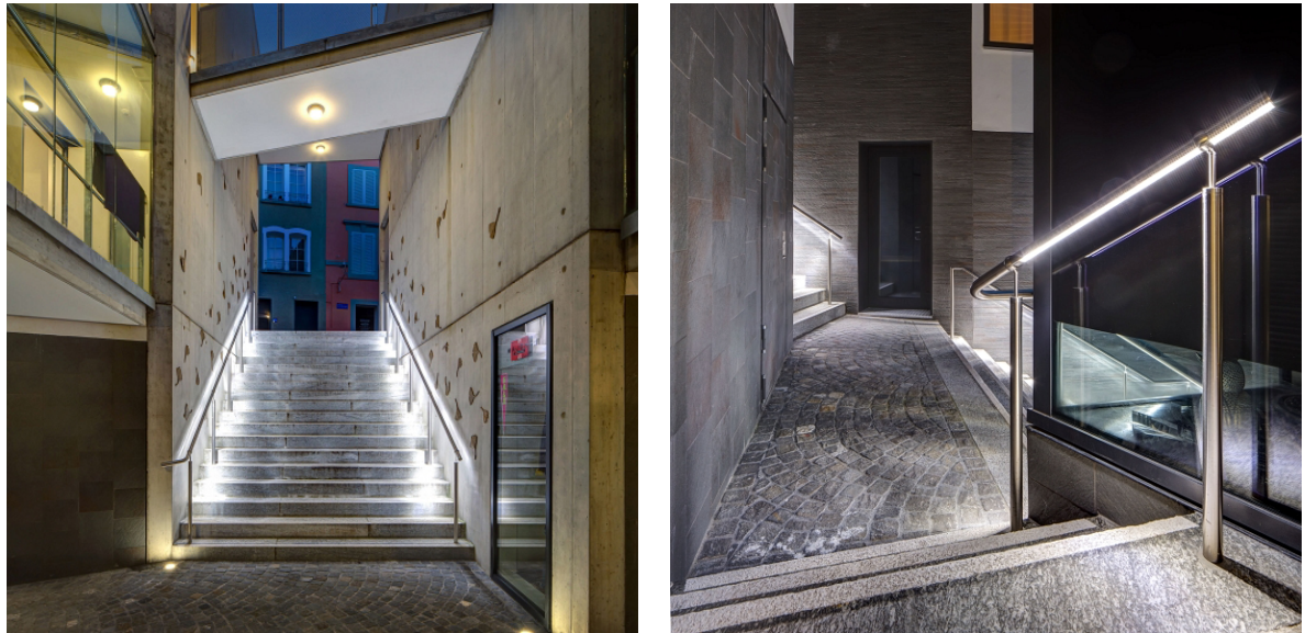
Abbildung 18: Im Quartier du Rôtillon von Lausanne werden die Treppen mit im Handlauf platzierten LED zusätzlich beleuchtet. Die einzelnen Absätze sind zudem noch mit weissen, rutschfesten Streifen versehen, die den Kontrast erhöhen (Quelle: Ville de Lausanne 15 ).
